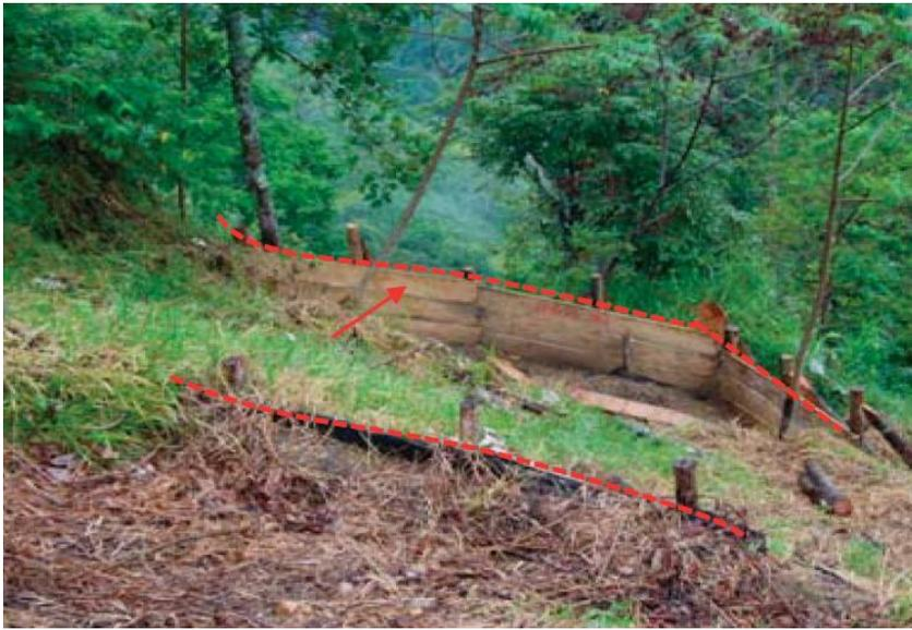
Fig. 16. Aspecto de un trincho establecido en un área con pendiente fuerte.
