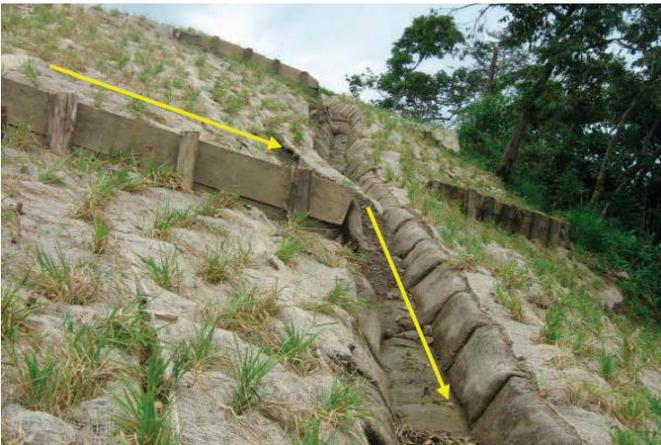
Figura 23. Imagen de un colector para recoger el agua que llega a los cortacorrientes
