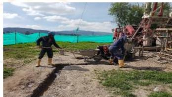
Extracción de sedimentos de canales de circulación de lodo con raqueta y pala.
